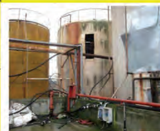
Fasi svuotamento e messa in sicurezza serbatoi B - 2008
